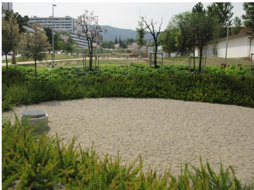
Figura 58: Balsa de infiltración. Can Cortada (Barcelona).
