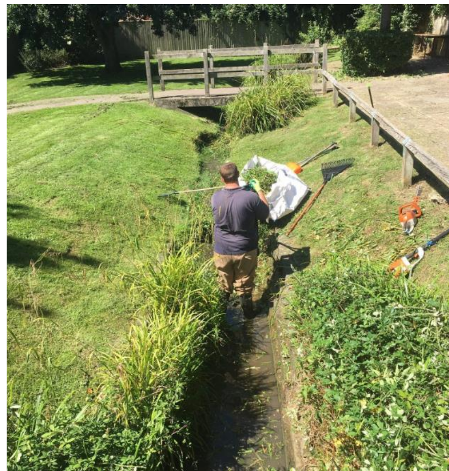
Figura 34: Mantenimiento de cuneta vegetada. Fuente: 4th Corner Landscaping.
