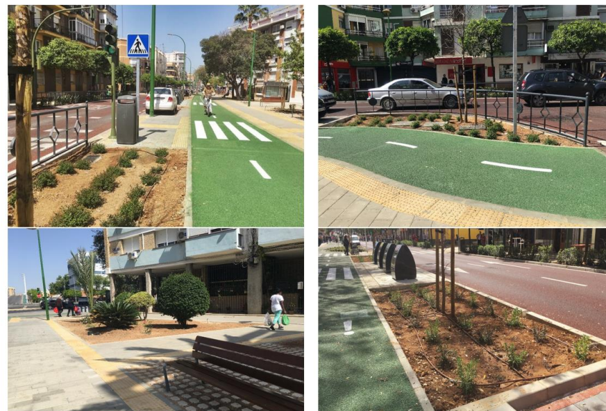
Figura 42: Pavimento permeable y zona de biorretención implementada en la Av. del Greco (Sevilla).
