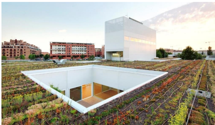
Figura 13: Cubierta vegetada en el Centro de Ocio de mayores Río Henares (Azuqueca de Henares). Fuente: Abalos+Sentkiewicz AS+.
