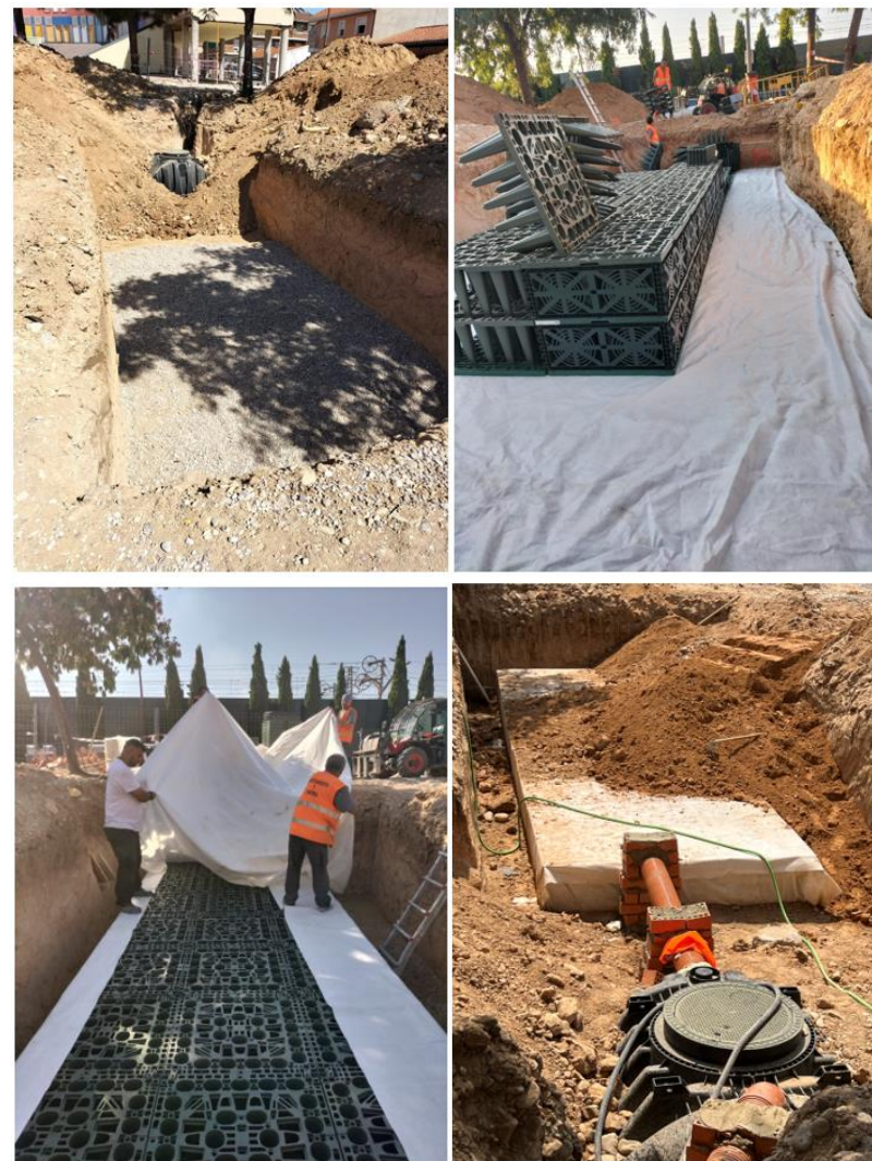
Figura 41: Proceso constructivo de los depósitos reticulares en el Learning Center.
