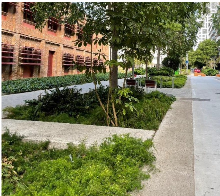
Figura 45: Parterres inundables en la Calle Cristóbal de Moura de Barcelona.
