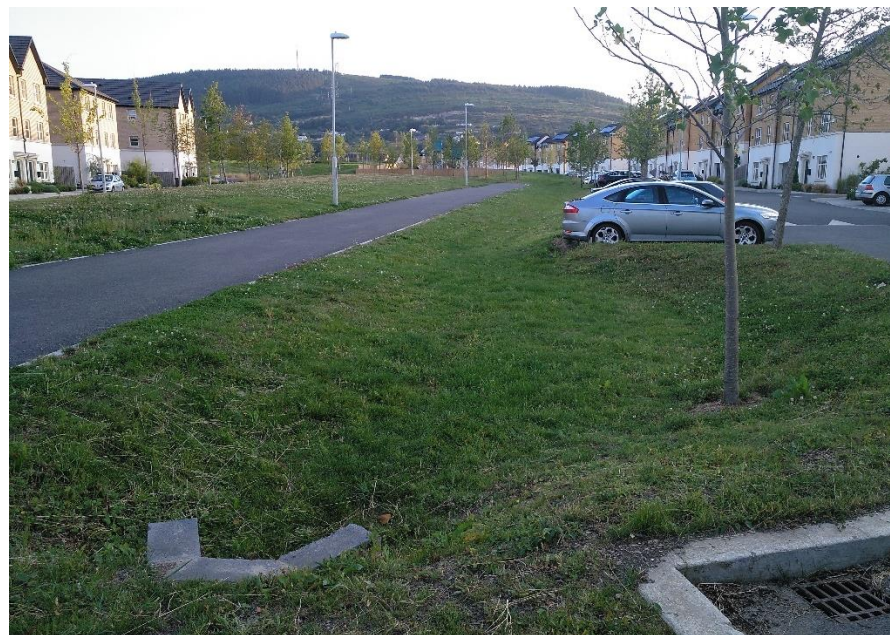
Figura 15: Cuneta vegetada en Irlanda.
