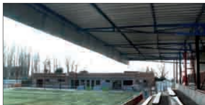
Arriba, el primer teniente de alcalde, el alcalde y el concejal de Deportes visitan los nuevos vestuarios. Abajo, vista exterior del edificio desde el campo de fútbol
