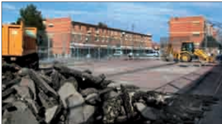
Las obras, que tienen un plazo de ejecución de un mes, comenzaron el 27 de enero
