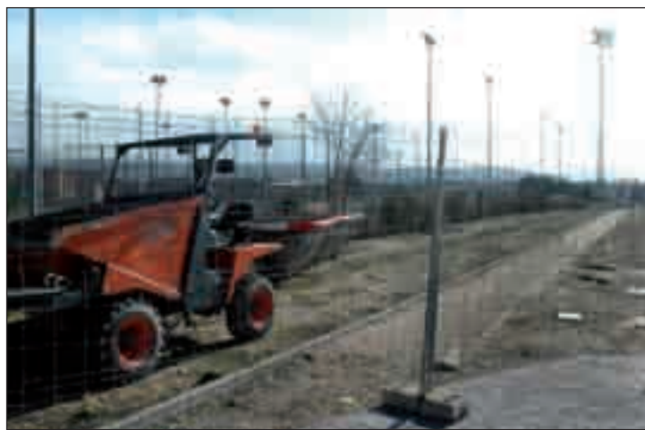
Las obras, que dieron comienzo el 27 de enero, fueron adjudicadas por cerca de 780.000 euros a la empresa Obras Coman, S.A.
