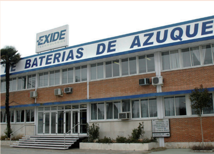
Arriba, instalaciones de Mercedes Benz en Miralcampo. Debajo, fachada de Exide Technologies
