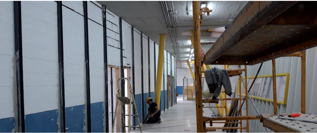
Los trabajos se están desarrollando en la primera planta del edificio
