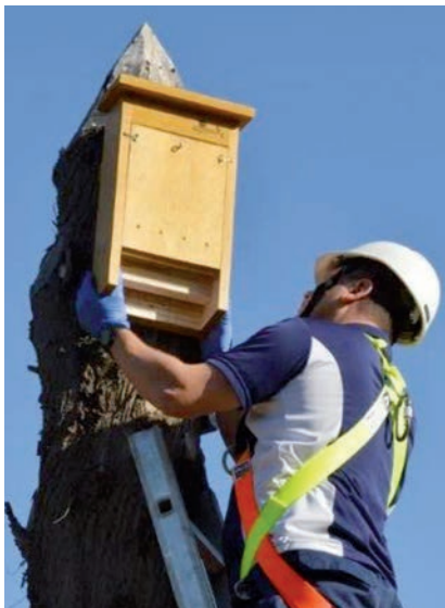
Colocación de una de las cajas
