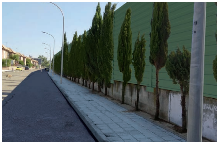
Imagen que recrea la instalación de pantallas en uno de los tramos en los que van a acometer estos trabajos
