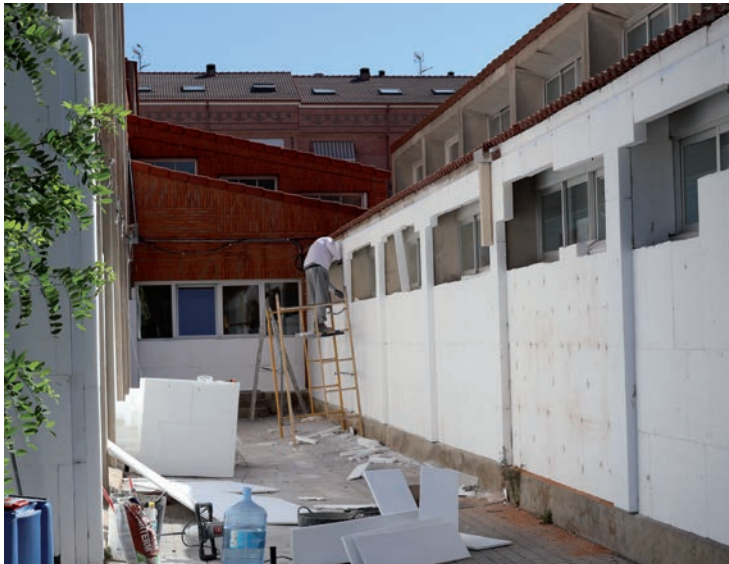
Trabajos de instalación del material aislante en uno de los edificios
