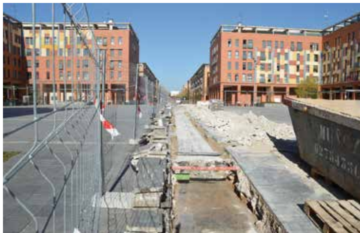
Se van a sustituir las antiguas canaletas para la recogida del agua de lluvia y se va a colocar una nueva instalación de saneamiento
