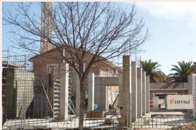
La constructora ha finalizado la estructura de la primera planta, una vez completadas las perforaciones para el sistema de geotermia
