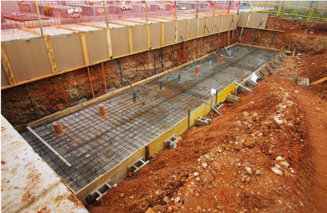
Las obras han comenzado con los trabajos de excavación y cimentación de las fosas
