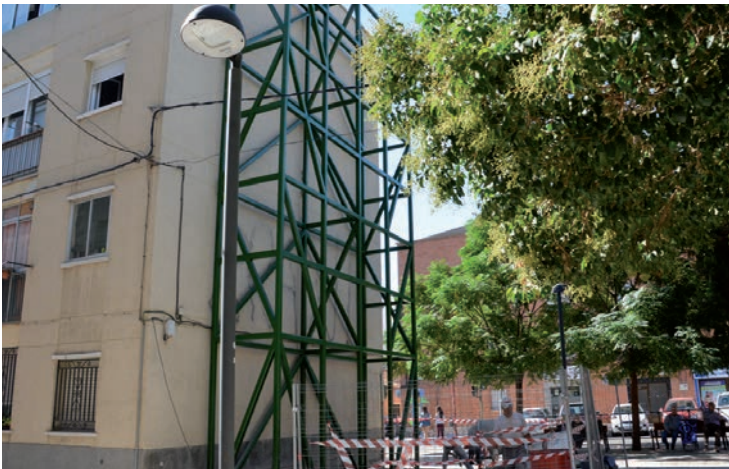
Trabajos de instalación de la estructura sobre la que se dispondrán las especies del jardín vertical
