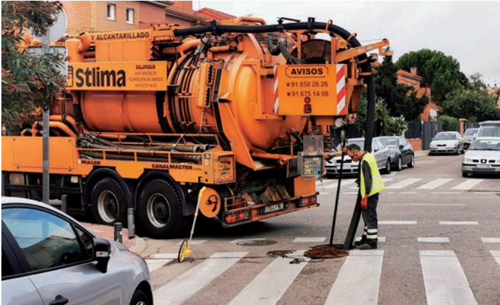
Sobre estas líneas, trabajos de limpieza de colectores en el barrio de Vallehermoso y debajo, inspección con cámara
