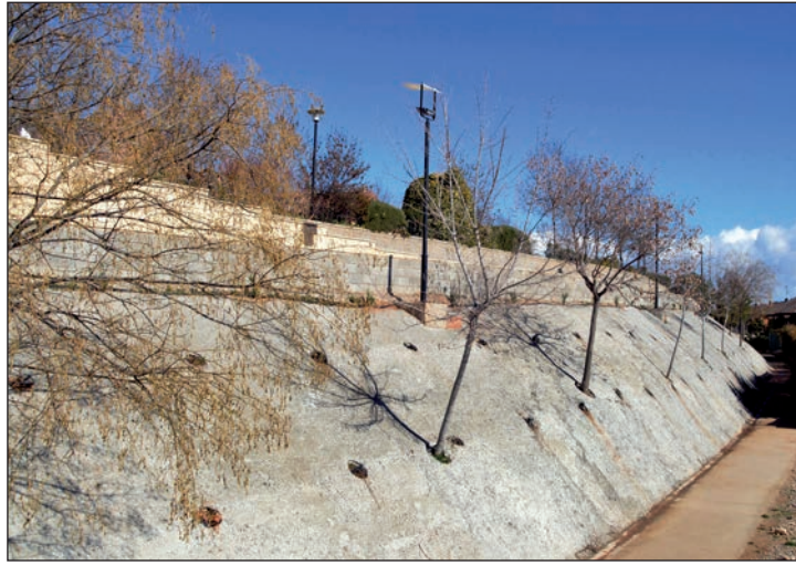
Las plantas trepadoras recubrirán el hormigón proyectado de los taludes
