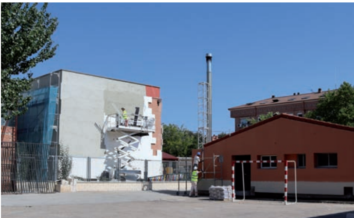
Obras que el Ayuntamiento está realizando para mejorar el aislamiento de la envoltente del CEIP La Paz
