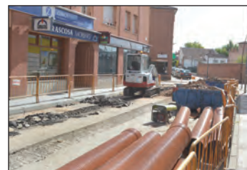
Trabajos en la avenida de la Paz para renovar la red de agua potable
