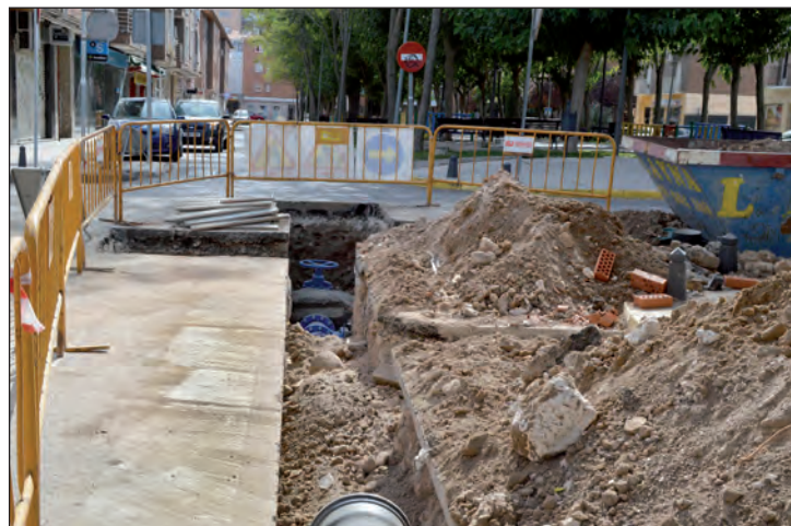
Obras en el bulevar para la instalación de las nuevas conducciones
