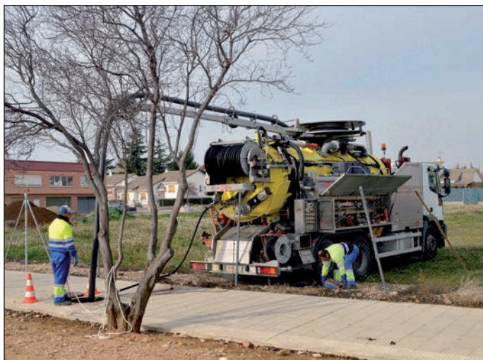
La actuación ha supuesto la limpieza y posterior revisión con cámara de una conducción, que recoge el agua procedente del barrio de Asfain
