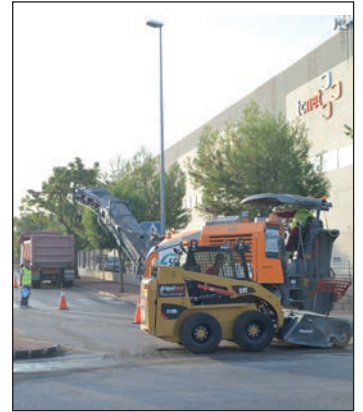
Trabajos de fresado previos al asfaltado en la avenida de Miralcampo
