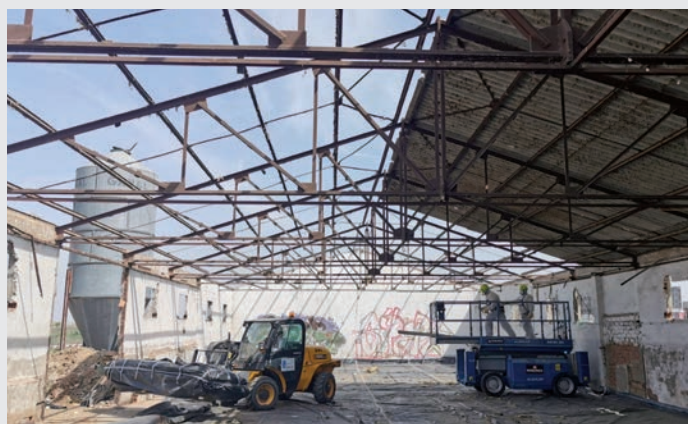
Máquinas trabajando en la retirada de la cubierta de una de las viejas naves agrícolas incluidas en el proyecto de demolición
