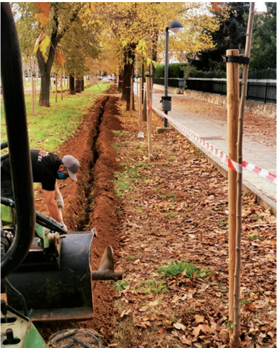
Se excavó una zanja para alojar la tubería de goteo
