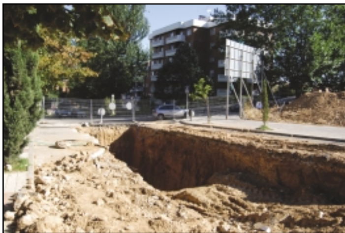
Zanja en la avenida de la Constitución para instalar el colector.
