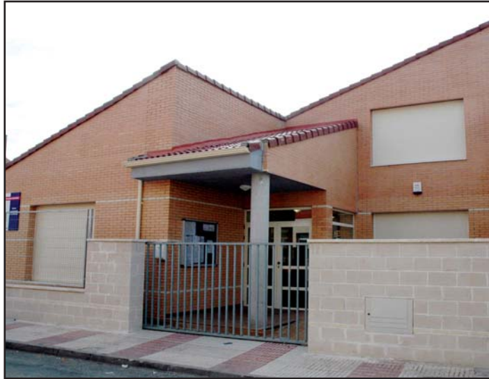
El Centro de Atención Temprana estará situado en la planta superior de la guardería municipal La Noguera
