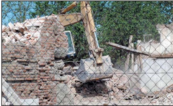
Antes de la demolición se han catalogado los elementos a preservar.
