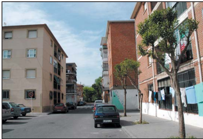
Este programa abordará la remodelación integral de la zona comprendida entre la N-320, la carretera de Torrelaguna y la calle Postas.
