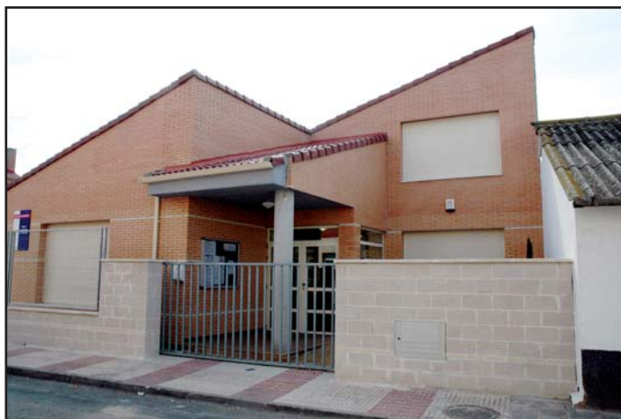
El Centro de Atención Temprana estará en la planta superior de la guardería La Noguera
