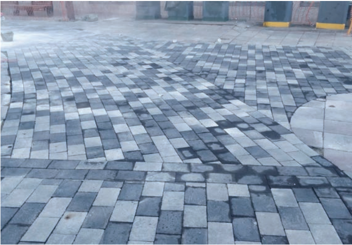
La obra se centra en la mejora del pavimento de la plaza en distintas zonas
