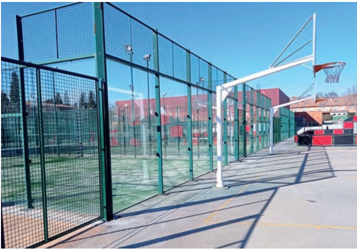
Nuevo cerramiento en la pista de barrio de la zona Arroyo del Vallejo
