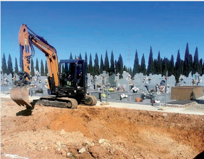
Obras de ampliación del cementerio municipal de Azuqueca
