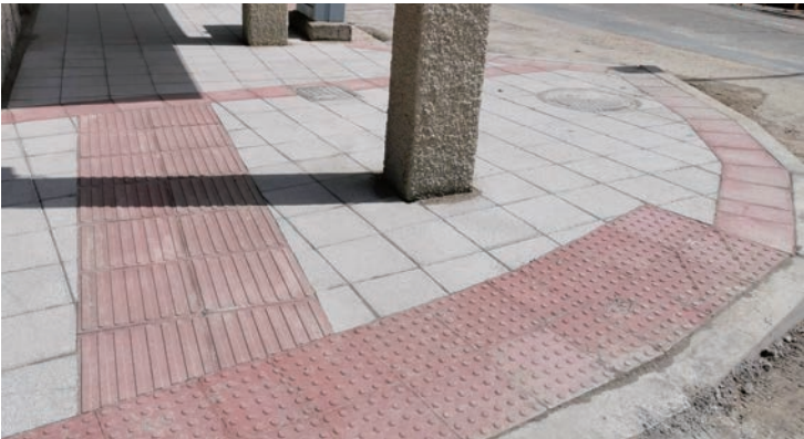
Fotografía de las aceras en una de las zonas de la avenida en las que ya se ha actuado
