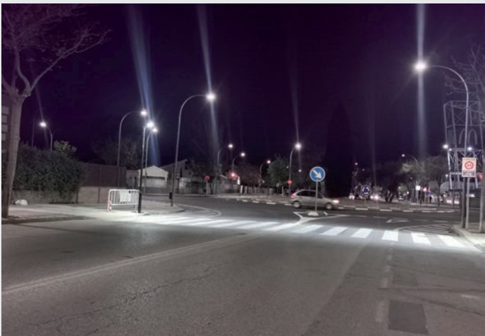
Uno de los pasos de peatones, en la avenida del siglo XXI, en los que se ha instalado el nuevo alumbrado
