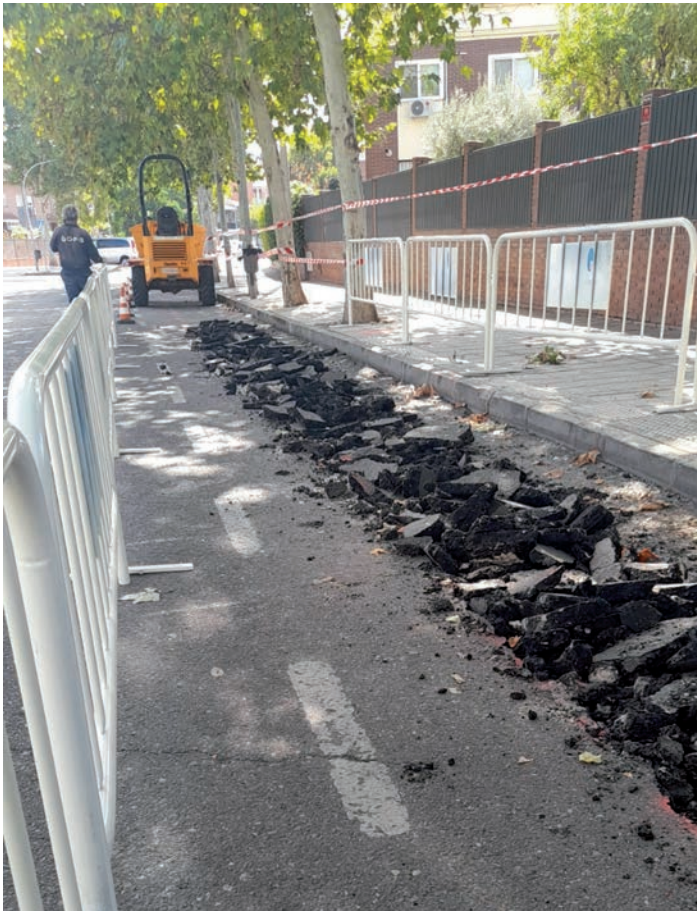
Trabajos de apertura en una de las calles en las que se va a proceder a la mejora de la red de agua potable
