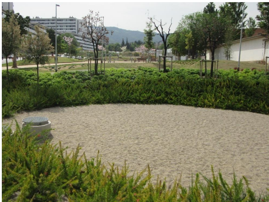
Figura 58: Balsa de infiltración. Can Cortada (Barcelona).
