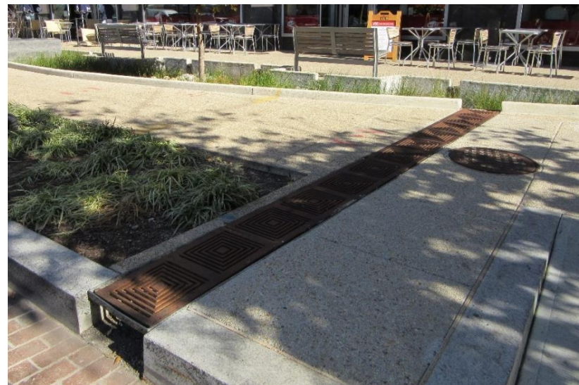
Figura 26: Elemento de entrada hacia un jardín de lluvia en Washington DC (EEUU).
