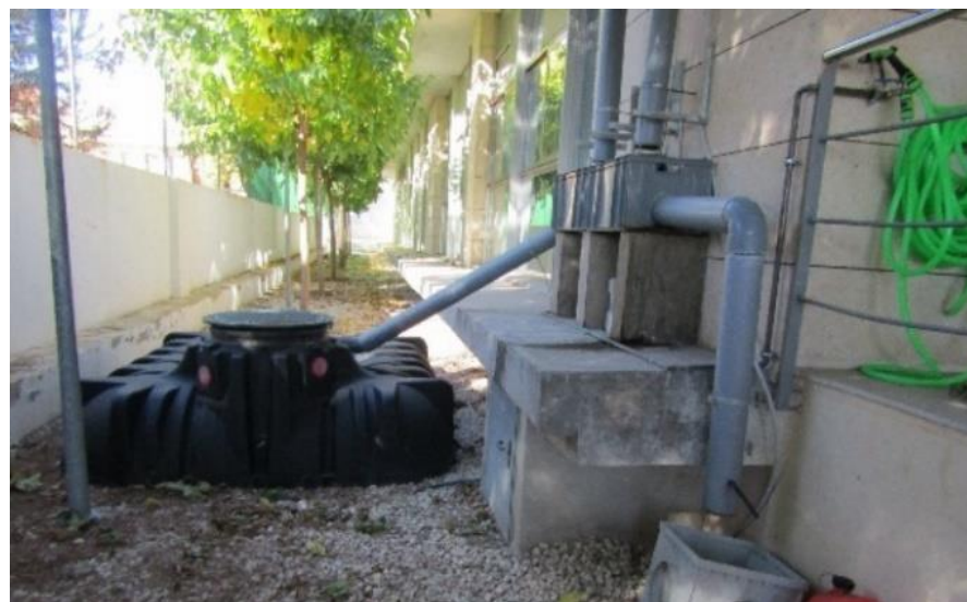
Figura 12: Aljibe en Benaguasil (Valencia).
