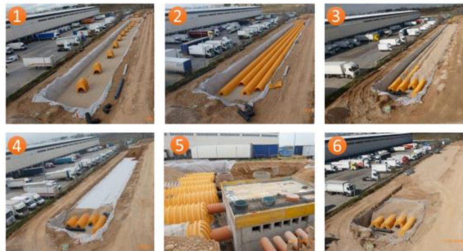
Figura 39: Proceso constructivo depósitos reticulares en una nave industrial.
