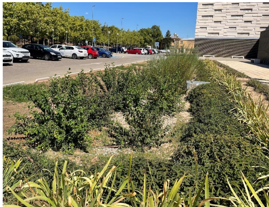
Figura 19: Zona de biorretención en el municipio de Tudela (Navarra).
