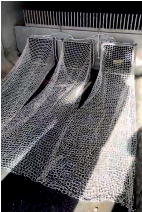
Redes instaladas en la salida del colector general de la Estación Depuradora de Aguas Residuales
