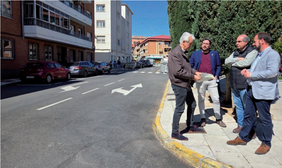
Visita a las obras de asfaltado ejecutadas en la calle Soria
